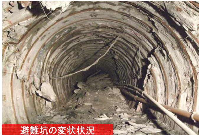
支保工や吹付コンクリートの変形
