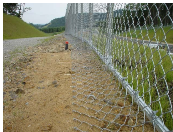
小動物の侵入防止のために 下部を閉塞
